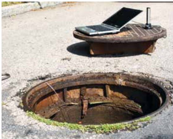
Installation av mätare i brunn
