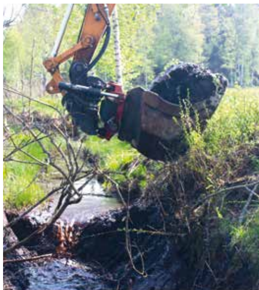
Figur 5. Pågående underhåll av dike i Hymans dikningsföretag från 1939. Foto: Markus Hoffmann
